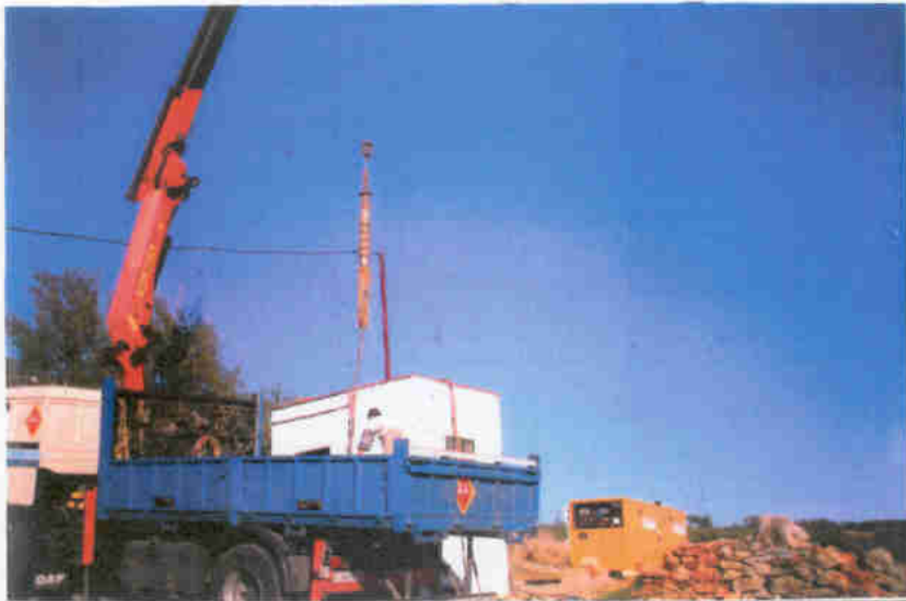
Desmontaje de la bomba del sondeo.
