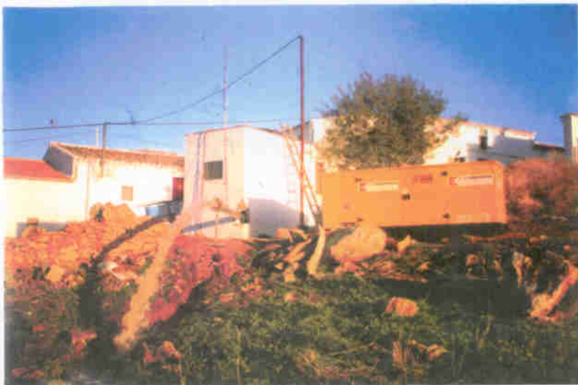
Extracción de agua con caudal de 60 l/seg.
